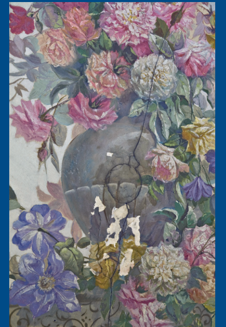
De verfschollen van het olieschilderwerk van dit bloemstillevan zijn losgeraakt. Ook is er een scheur opgetreden in het muurwerk. Een schade aan een dergelijke muurschildering verdient een deskundige conservering en restauratie.
